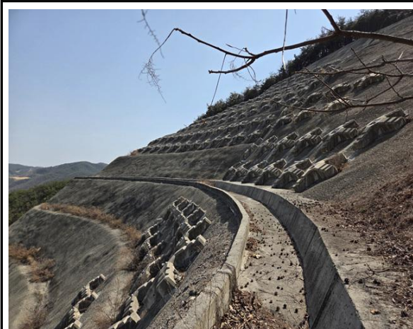
위 치 3소단배수로 전경 현 황 전경
