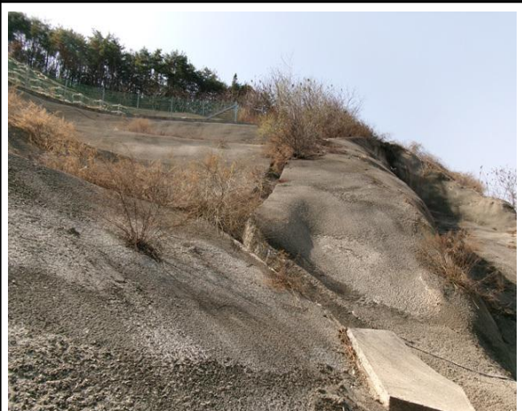
위 치 숫크리트, 수직도수로 현 황 전경
