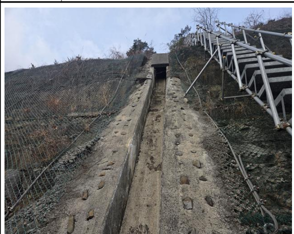
위 치 수직도수로, 점검계단 현 황 전경
