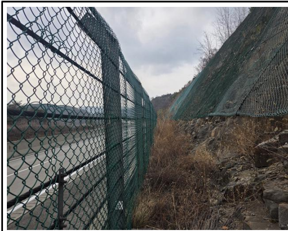
위 치 하단 및 낙석방지울타리 현 황 전경
