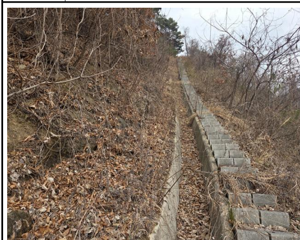
위 치 산마루측구 현 황 전경
