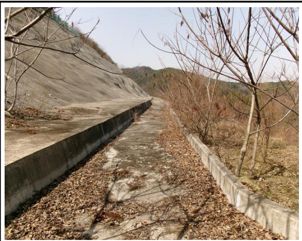
위 치 1소단배수로 현 황 전경
