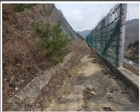
위 치 소단배수로, 낙석방지울타리 현 황 전경
