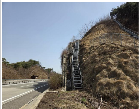
위 치 점검계단 현 황 전경
