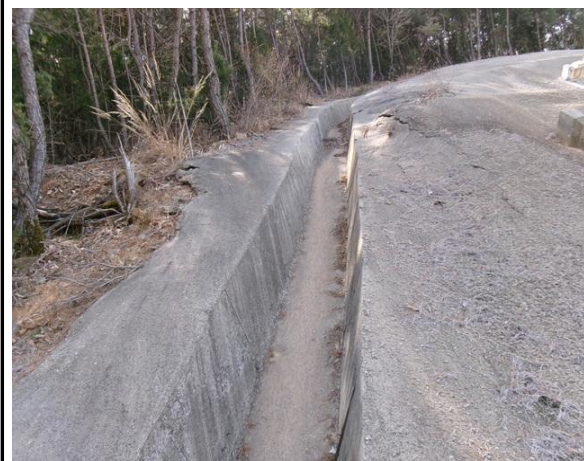
위 치 산마루측구 현 황 전경
